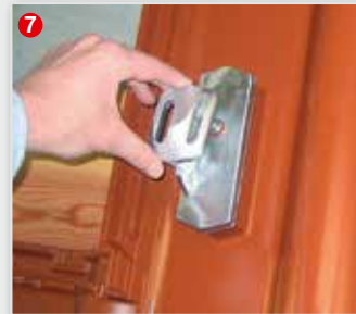
7 Anschließend den montierten Solarträgeraufsatz nach Dachneigung ausrichten.
